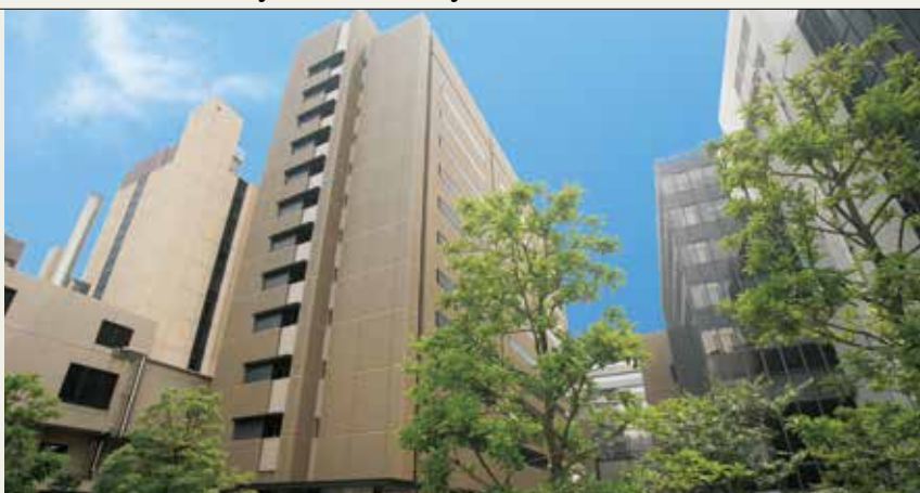
芝共立薬学図書館（芝共立キャンパス3号館3階） Shiba-Kyoritsu Library of Pharmaceutical Sciences (Third floor of Bldg. 3)
