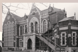
震災後の増築及改修工事
