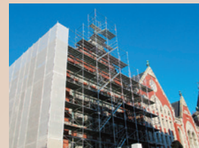
足場に囲まれた旧館
